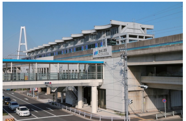
名古屋臨海高速鉄道あおなみ線『金城ふ頭駅』
